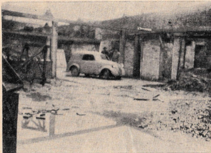
NOUVEAUX ATELIERS EN CONSTRUCTION
